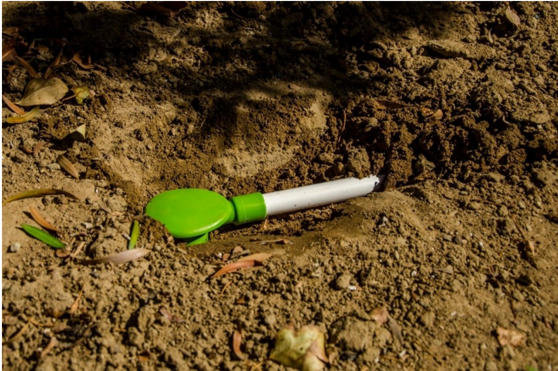
Figura 4. Ocultar el cable de la sonda: utilice un conducto de plástico para ocultar y proteger el cable. Cubra la excavación con tierra removida y compacte ligeramente.
